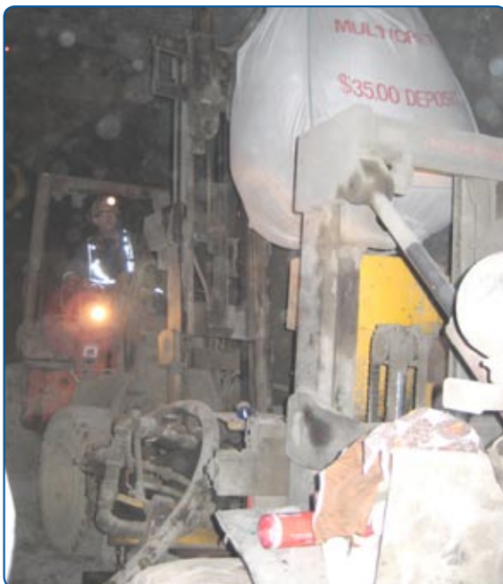
Figure 3 : Préparation de la machine à béton projeté
