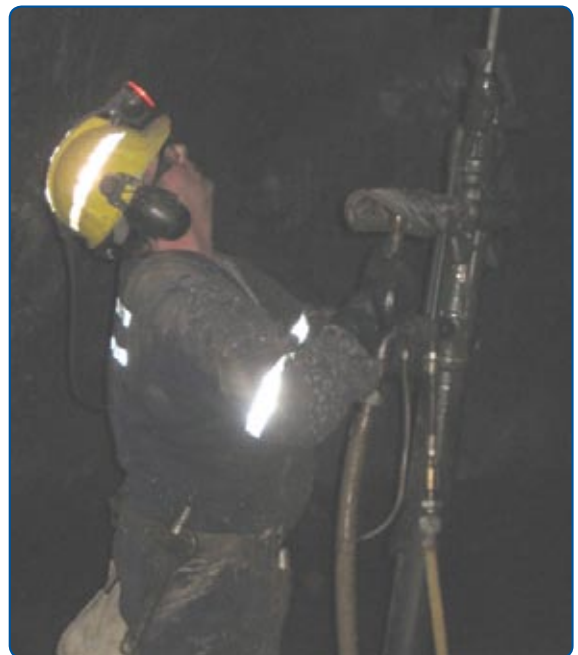
Figure 4 : Utilisation d'une foreuse verticale pour forer un trou au plafond
