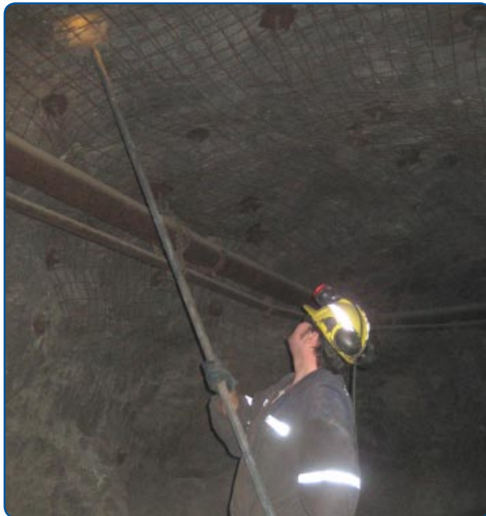
Figure 2 : Purge du toit d'une galerie
