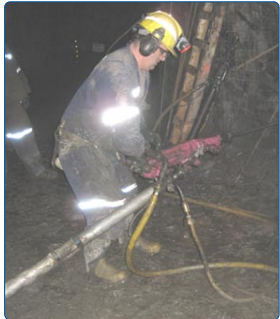
Figure 2 : Utilisation d'une foreuse sur béquille pour installer des boulons
