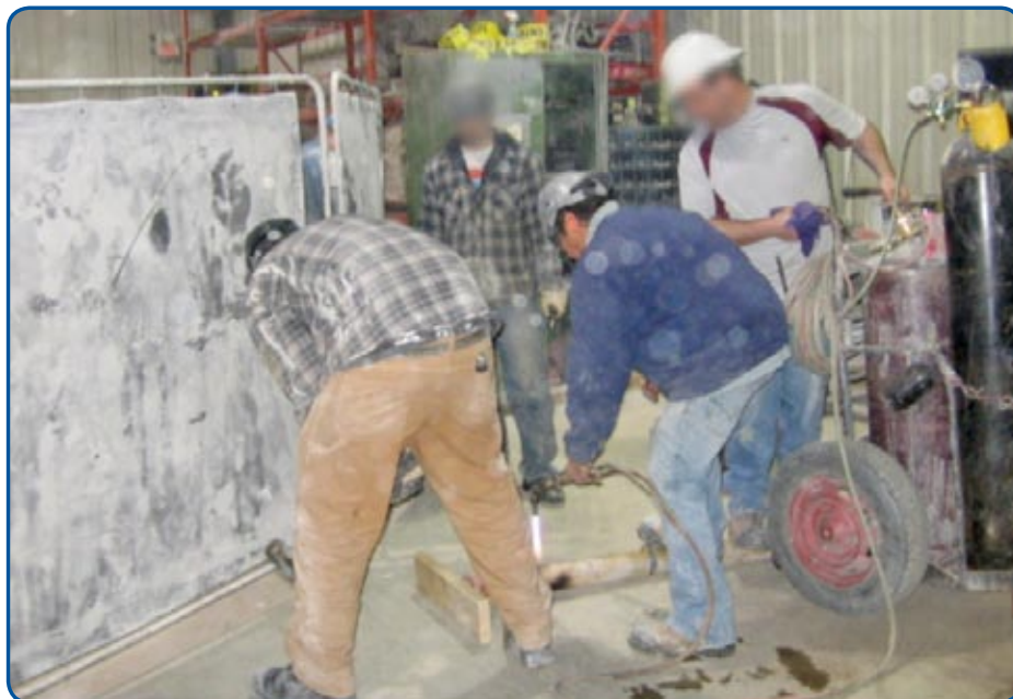
Figure 2 : Travailleur utilisant un chalumeau pour effectuer des réparations sur une section de tuyauterie.
