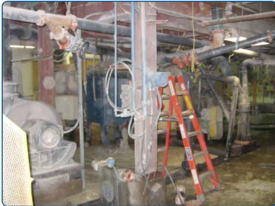
Figure 1 : Échelle installée pour la réparation de tuyaux.
