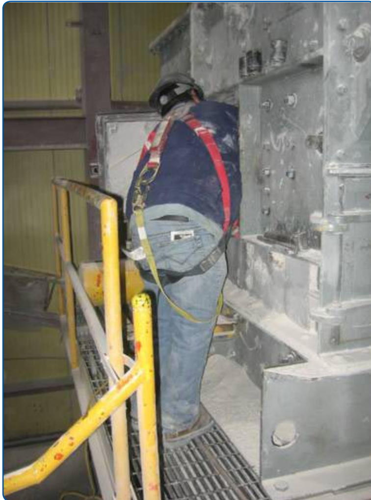
Figure 1 : Entretien d'un concasseur. Remarque : le travailleur porte une ceinture munie d'un harnais et a une liste de contrôle de sécurité de consultation rapide dans sa poche arrière.
